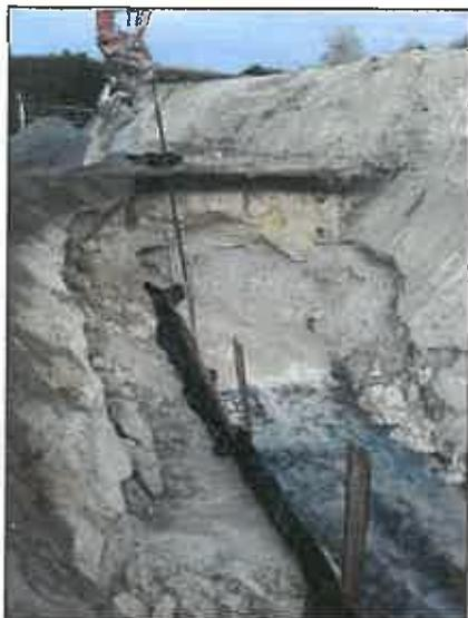
**Terrassement pour mise en place du puits d'attaque pour travaux de forage à la tarière**
