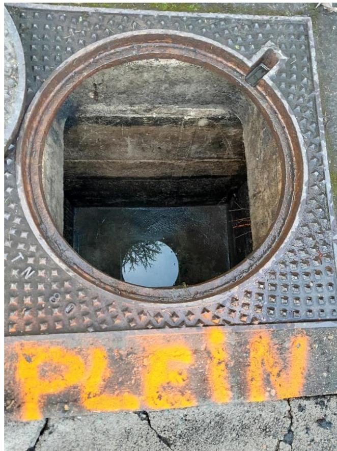
**Photos d'une bouche d'engouffrement avant, pendant et après l'intervention de curage/pompage.**
